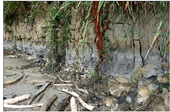
Abb. 26: Letten an einem Baggersee bei Weißingen im Landkreis Günzburg. Hier befindet sich die tonig-schluffige Schicht deutlich näher an der Bodenoberfläche als an den rund zwölf Kilometer donauabwärts bei Gundelfingen gelegenen Kiesseen.
